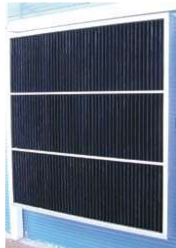
При содержании родительского стада бройлеров жалюзи комплектуются светозащитой.
